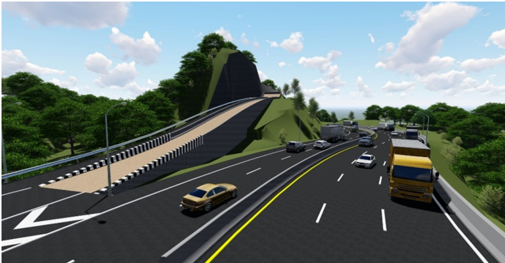
รูปที่ 9.5-2 ตัวอย่างที่หยุดรถฉุกเฉิน (Emergency Escape Ramp) ในทางลงเขา
