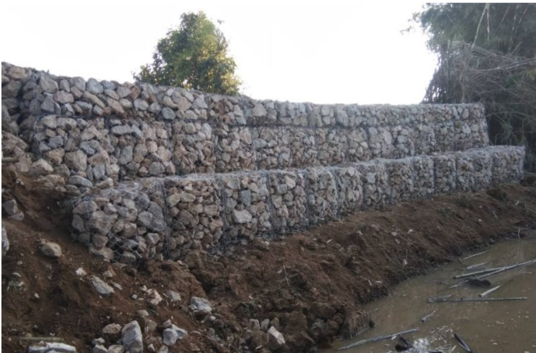
รูปที่ 7.4-4 รูปแบบก่อสร้างกล่องลวดตาข่าย
