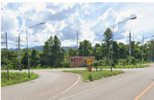
เสาไฟฟ้าส่องสว่างบริเวณทางแยก
