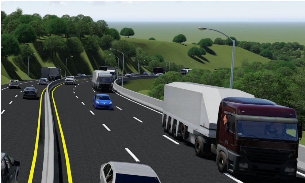
รูปที่ 9.4-1 ตัวอย่างช่องจราจรไต่ลาดชัน (Climbing Lane)
