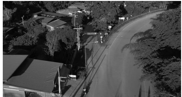
กม.138+800 จุดตัด มส.4014 (บ้านสบป่อง)
