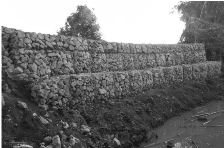
รูปที่ 7.5-4 รูปแบบก่อสร้างกล่องลวดตาข่าย
