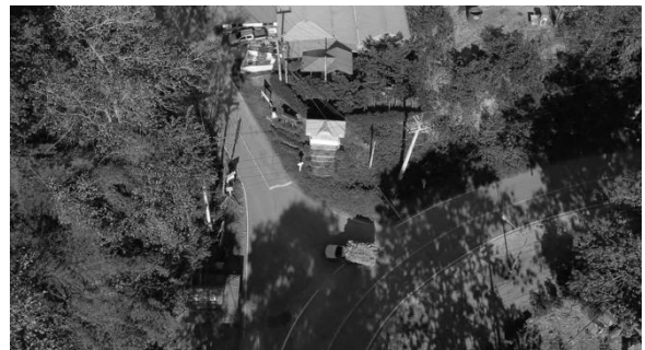
กม.162+900 จุดตัด มส.4015 (บ้านน้ำของ)
