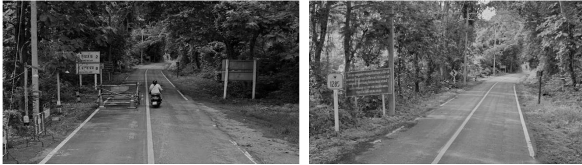
รูปที่ 7.4-1 สภาพพื้นที่บริเวณทางหลวงหมายเลข 1285
