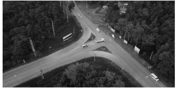
กม.97+340 จุดตัดทางหลวงหมายเลข 1395 (แยกเลี้ยวเมืองปาย)
