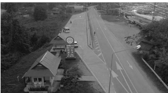
กม.166+575 จุดพักรถกรมทางหลวง
