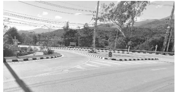
กม.89+930 จุดตัดถนนท้องถิ่น (อบต.ทุ่งยาว)
