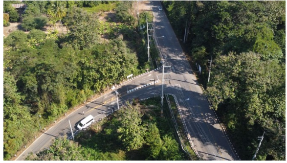
กม.196+100 จุดตัด มส.4001 (บ้านกุงไม้สัก)
