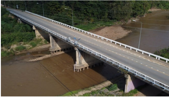
กม.197+441 สะพานข้ามแม่น้ำปาย
