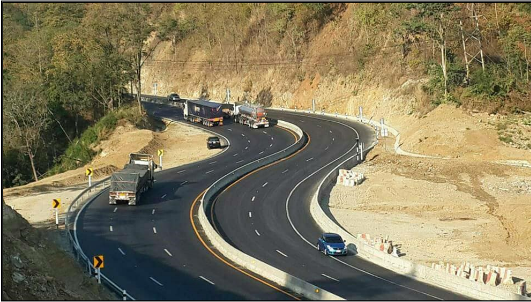
รูปที่ 8-31 แสดงตัวอย่างช่องจราจรไต่ลาดชัน (Climbing Lane)
